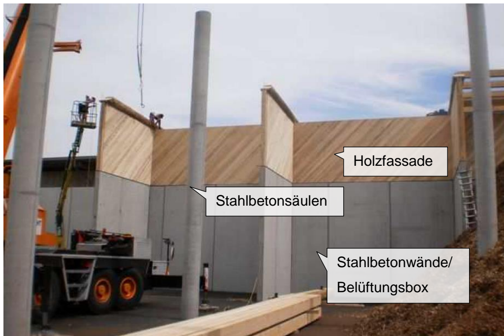
Abbildung 10: Bau Lagerhalle – Archivfoto
